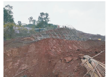
图 4 坡顶覆盖层开挖情况
