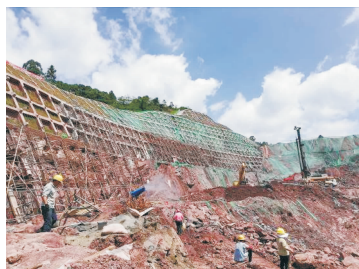
图 6 锚索+格构+抗滑桩支护区实景
